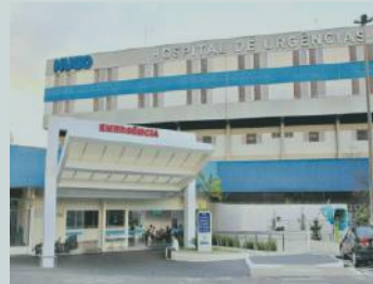
HOSPITAL DE URGÊNCIAS HUGO - GO
