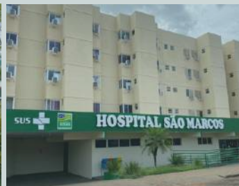
HOSPITAL ESTADUAL DE ITUMBIARA SÃO MARCOS - GO
